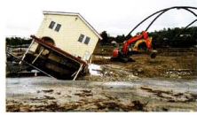
濁流に押し流された清水町の住宅
